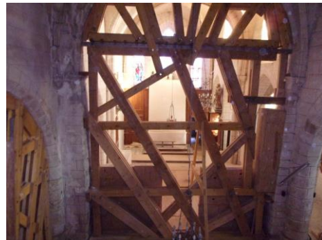
Renforcement de la structure à l'intérieur.
